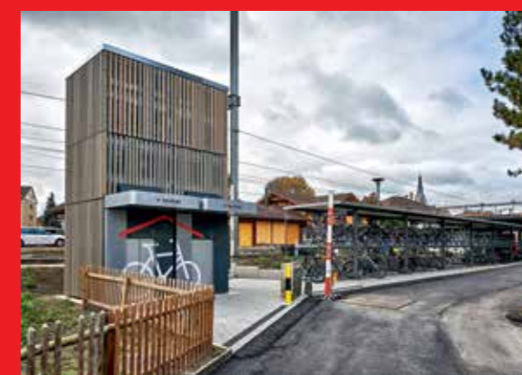
Am SBB-Bahnhof Münchenbuchsee läuft das Pilotprojekt mit zwei Velotürmen.
