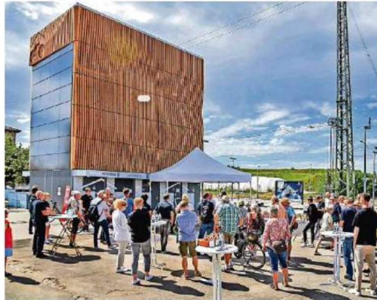
Von weitem gut sichtbar ist das neue Mühlacker Fahrradparkhaus am Lienzinger Tor in direkter Nähe zum Bahnhof.
