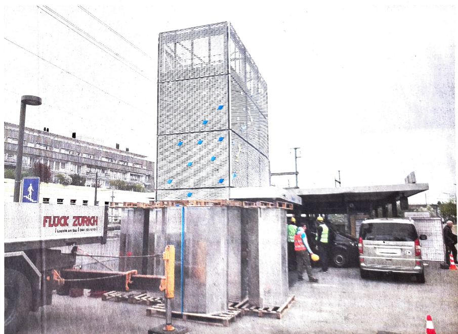
Die am Dienstag installierte Veloparkanlage (Turm) kann ab kommenden Mittwoch genutzt werden.
